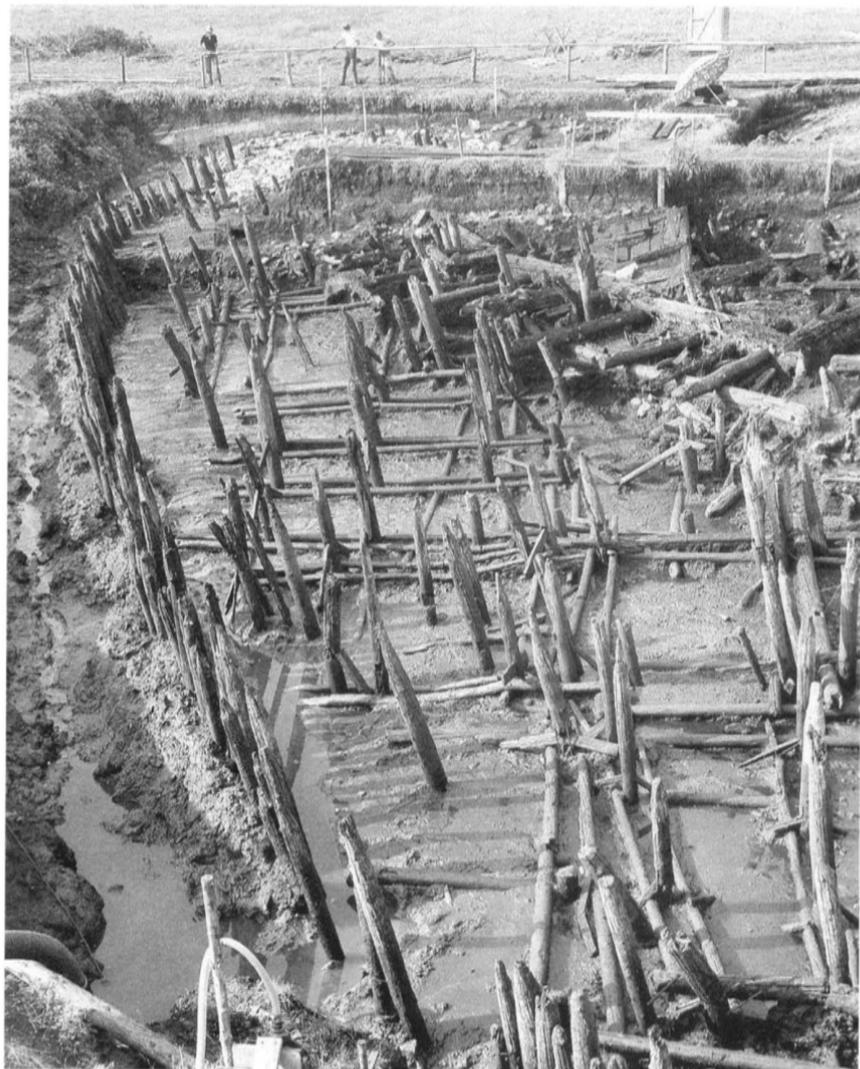
Fig. 32 - Scavo della palafitta con fondazione a travi continue nella zona I (fase Fiavè 6; Bronzo medio avanzato). I pali verticali erano vincolati alla griglia formata dalle travi orizzontali, sulla quale scaricavano il peso della struttura soprastante (da PERINI 1984, p. 103)
