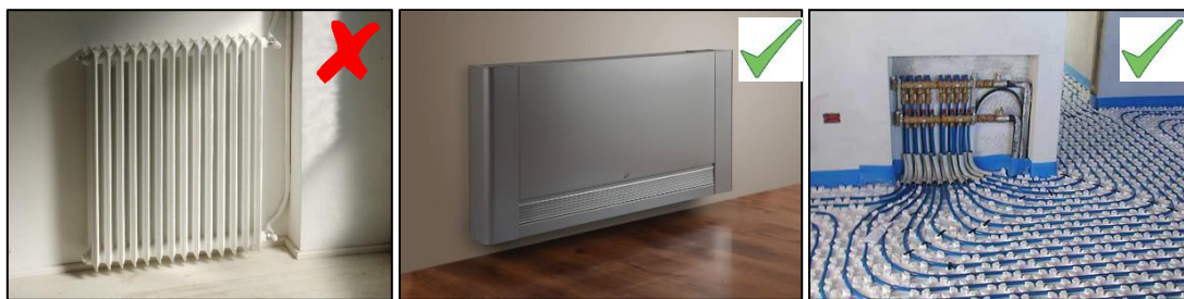
Figura 8: Tipologie usuali di terminali di riscaldamento, da sinistra: radiatore, ventilconvettore, pannelli radianti
