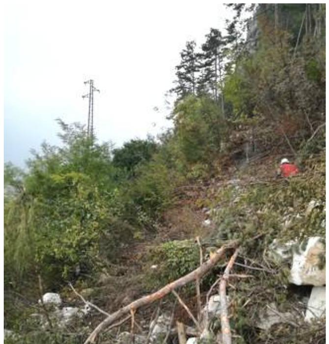
Versante dopo demolizione diedro con linea elettrica da 20kV nel tratto in cui si prevedono i lavori di posa della barriera paramassi
