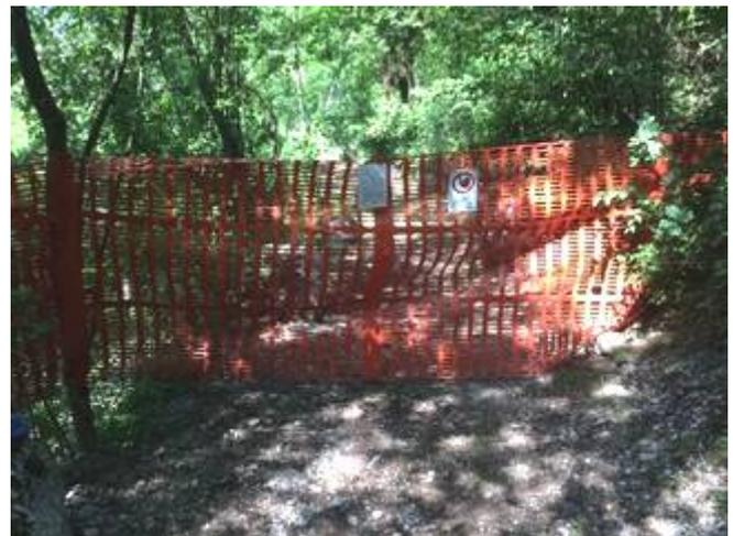
Si prevede la realizzazione della recinzione di cantiere sia con paletti di ferro o di legno e rete di plastica arancione.
