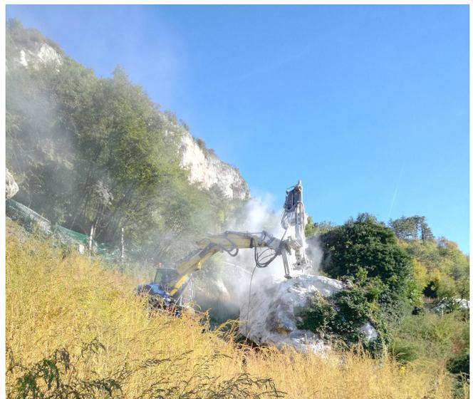
Si tratta di perforazioni da eseguire mediante sonda installata su mezzo speciale (in questo caso ragno). Le aste di perforazione sono da collegare (manovre) mano a mano che la perforazione si spinge in profondità. Le manovre sono effettuate da un operatore che dovrà movimentare le aste per agganciarle alle aste già fissate alla sonda allungando in tal modo la batteria.
