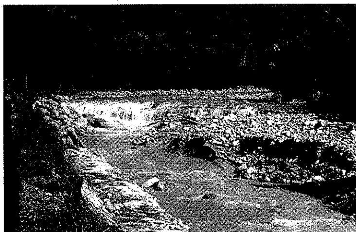
Erosione dell'alveo del fiume Sarca a monte del ponte di Villa Rendena
