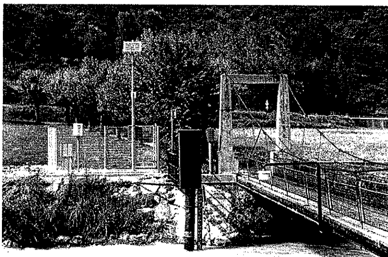
La passerella sul fiume Noce a Pellizzano, distrutta a causa dell'evento del 20 settembre 1999
