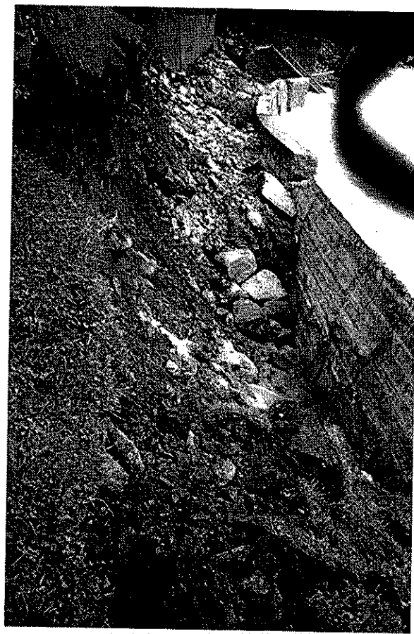
Argini del fiume Sarca a valle del ponte di Spiazzo (21/09/99)
