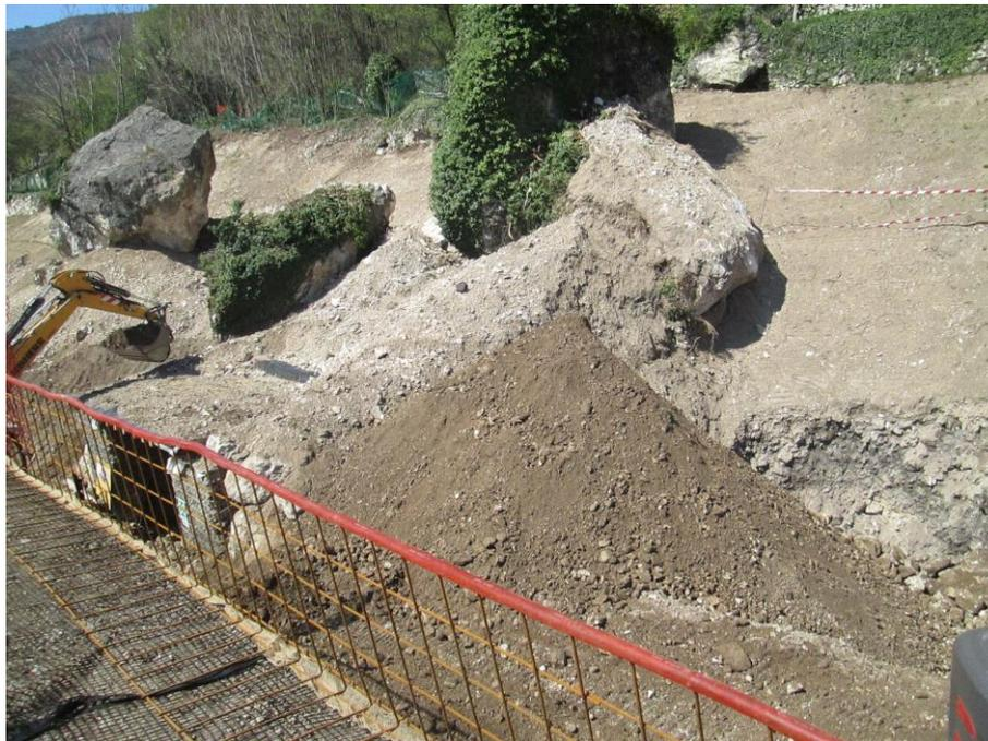
La frantumazione dei massi sarà pertanto possibile attraverso la realizzazione di fori verticali di piccolo diametro che saranno realizzati con perforatrice portatile.
