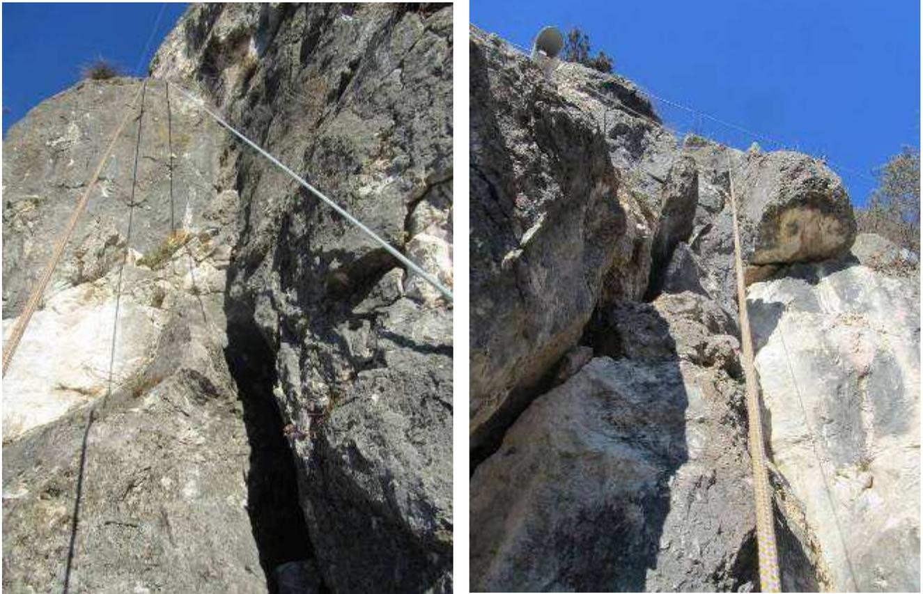
Foto 5.3; a sx fianco ovest, a dx fianco est; entrambi i "bordi" presentano VRU considerevoli allentati e separati dall'ammasso retrostante e dal prisma, ancorchè massivi
